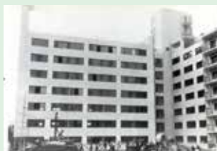
■ 都市に建設された高層アパート
